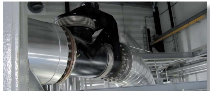
Prosperon patentoima painebalansoitu paljerakenne turbiinin höyrylinjassa.
